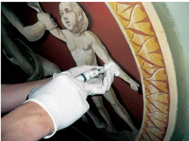
Il fissaggio del consolidante tramite siringhe
