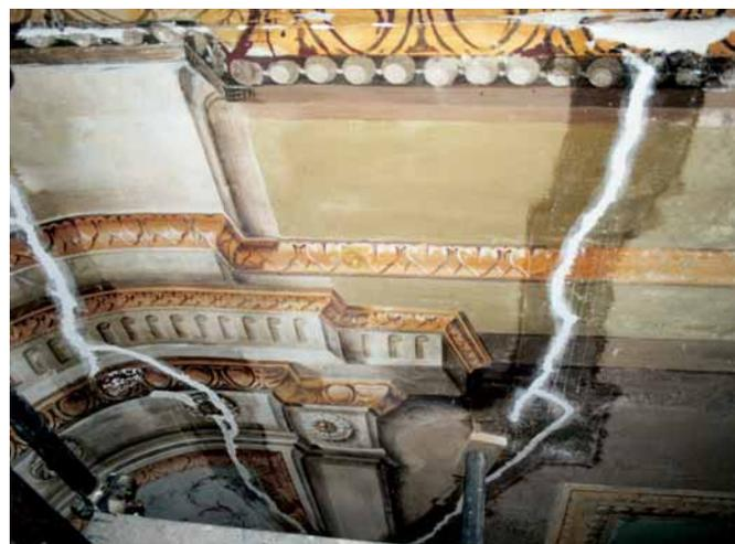
nali, con diverse concentrazioni di soluzioni con sali di carbonato di ammonio ed infine sono state rifinite alcune parti meccanicamente. L'incamottatura è stata restaurata ricomponendo i teli staccati dal supporto e lacerati foderandoli con garze incollate al supporto murario.
