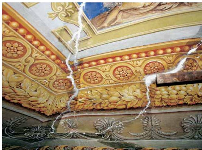
La riadesione tra supporto murario e arriccio, tra arriccio e intonaco, tra intonaco e intonachino dipinto è stata ottenuta iniettando da piccoli fori o da lesioni prima acqua e alcol (per veicolare più facilmente il consolidante, nelle sacche dei distacchi dei vari strati di intonaco), poi a bassa pressione, tramite siringhe con aghi o cannule, è stato iniettato il consolidante, una boiaccia a base di legante idraulico fillerizzato superfluido resistente ai solfati.
