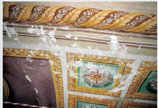
Particolari delle pareti e della volta: efflorescenze saline con sollevamento a scaglie, polverizzazione e caduta del colore
